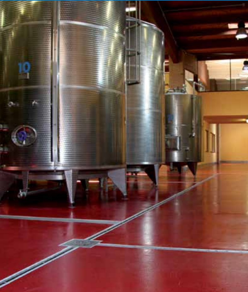
Bodega Vinicola San Patrignano Ospedaletto de Rimini (RN) - Italia Productos utilizados: Mapefloor CPU/HD
