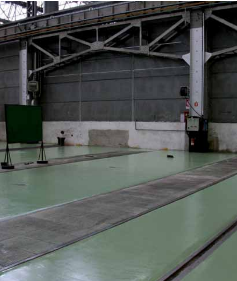
Almacenes OGR - Foligno (PG) - Italia Productos utilizados: Mapefloor System 31 Mapefloor System 91
