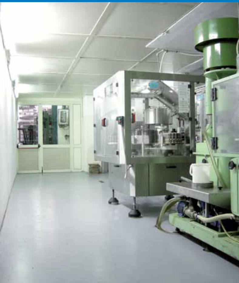
Oleificio Gargiulo - Sant'Agnello (NA) - Italia Productos utilizados: Mapefloor System 32
