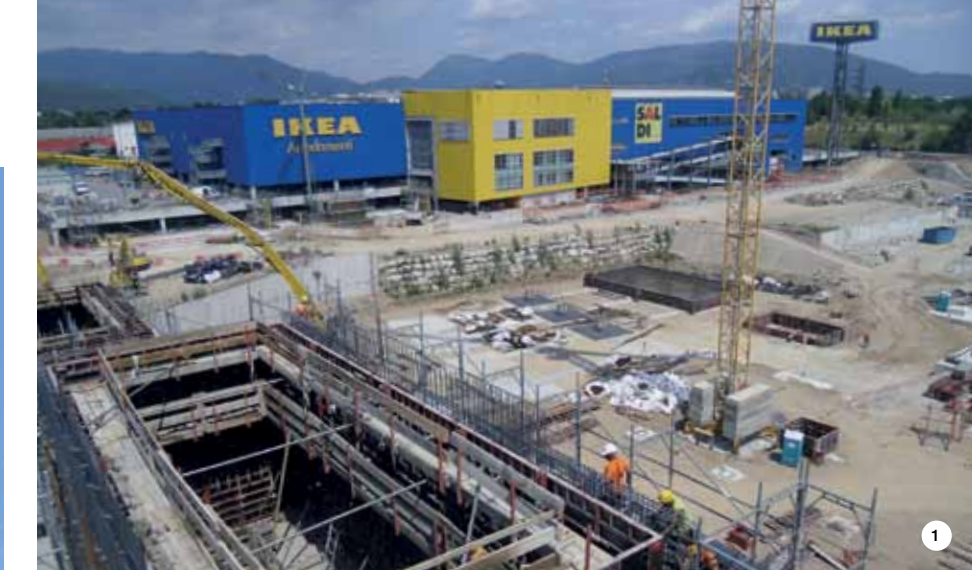
FOTO 1. Mapei ha fornito EXPANCRETE, MAPECURE SRA 25, DYNAMON XTEND W100 R e DYNAMON XTEND, additivi per il calcestruzzo utilizzati per realizzare i plinti di fondazione, i muri dei vani scala e degli ascensori e le solette.
