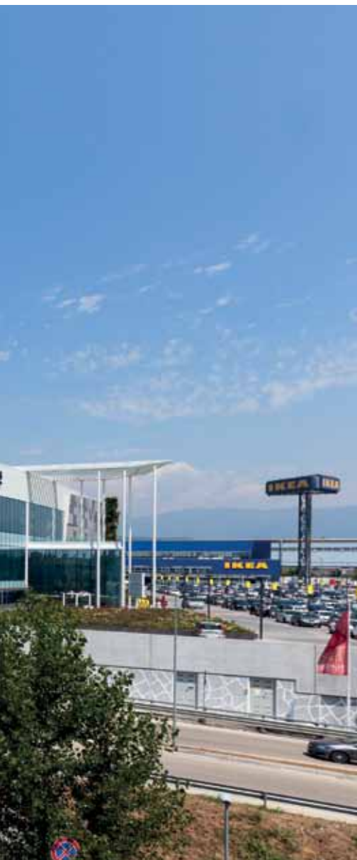
FOTO 2. Dove necessario, la rasatura di livellamento è stata effettuata con PLANITOP FAST 330.
