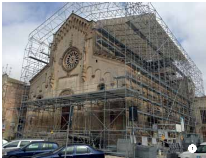
FOTO 1. Per le travi e le capriate del tetto è stato utilizzato il sistema MAPEWOOD, mentre per il rinforzo è stato applicato il sistema MAPEWRAP.
