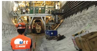
Productos de excavación de túneles
