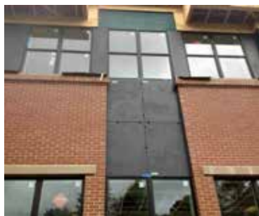
Paneles/losas de losetas de porcelana calibrada en una fachada exterior
