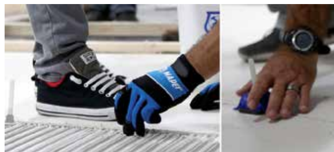
Ejemplo de loseta calibrada sobre loseta ya existente durante una renovación usando un sistema mecánico de nivelación de bordes
