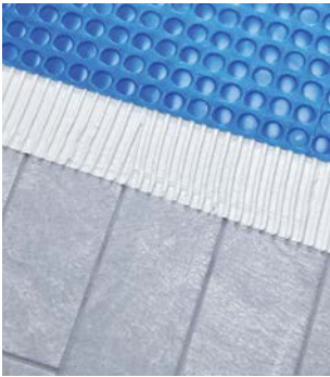
Losetas ya instaladas
