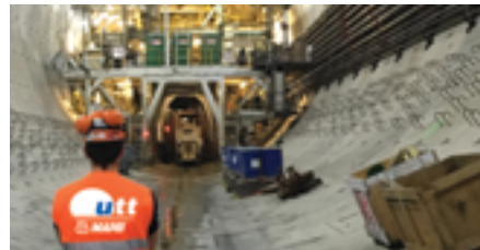
Productos de excavación de túneles
