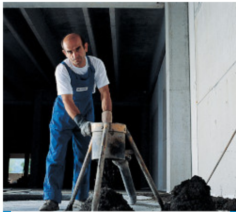
Batching a Mapecem mix
