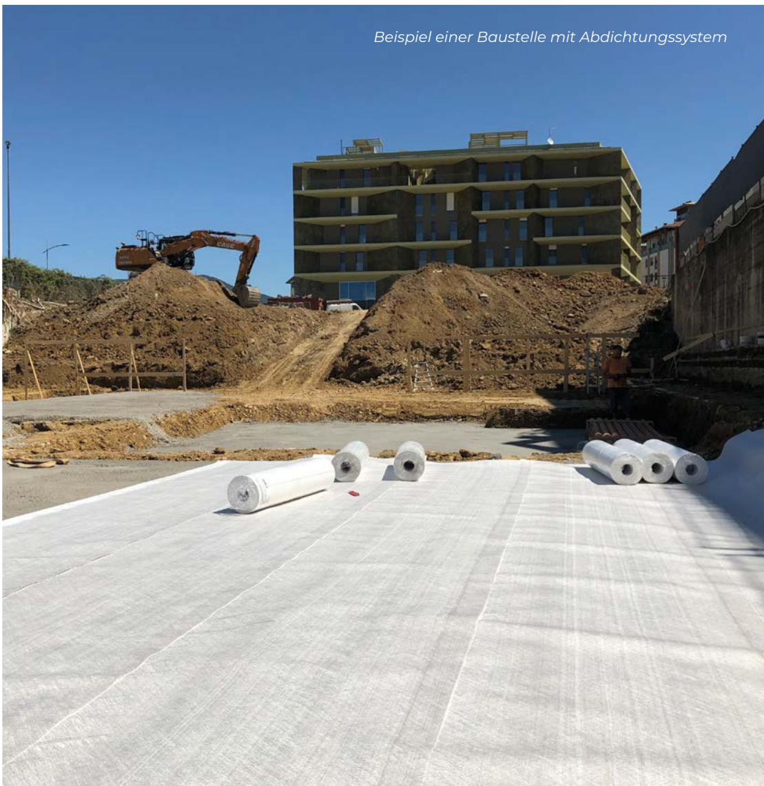
Einbringen der Bewehrung
