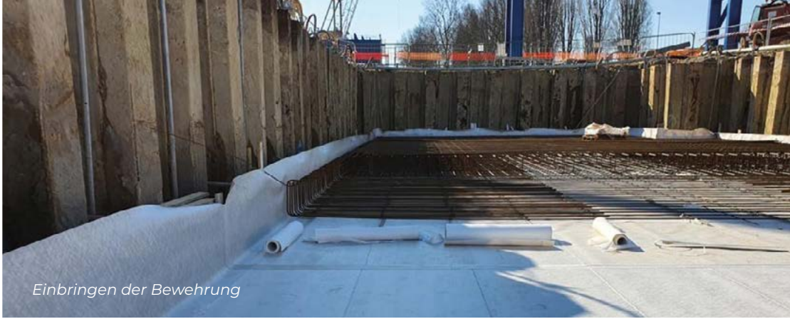
Beispiel einer Baustelle mit Abdichtungssystem
