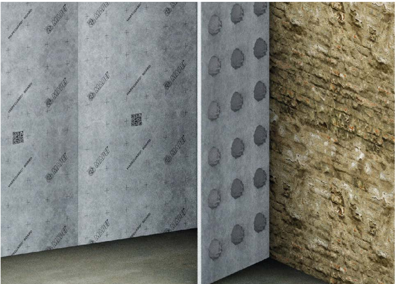
Verklebung der Platten mit Kleberrauten und -punkten
