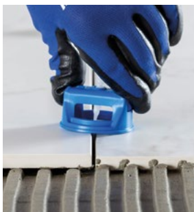
Vor der Feinnivellierung
