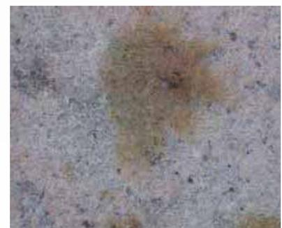
Oberflächenverfärbung, verursacht durch die Reaktion eisenhaltiger Minerale (z. B. Pyrit) mit alkalischer Feuchtigkeit aus dem Verlegesystem in Verbindung mit Sauerstoff
