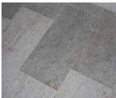
Optische Beeinträchtigungen des Natursteinbelags werden oft durch die Verwendung unterschiedlicher Klebemörtel ausgelöst
