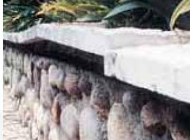
Verlust des Haftverbundes einer Naturwerksteinabdeckung durch thermische Längenänderung
