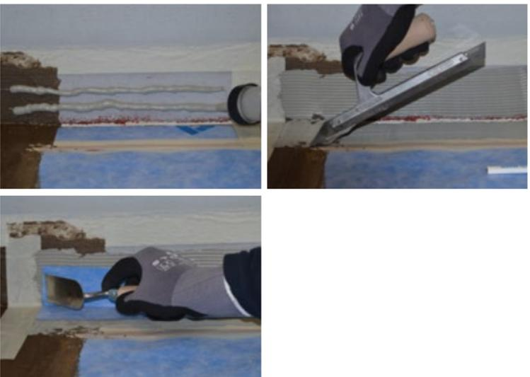
Variante 2: Verklebung der Dichtband-Systemkomponenten mit **Mapeflex MS 45**
