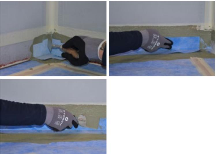
Variante 1: Verklebung der Dichtband Systemkomponenten mit **Mapelastic Turbo**
