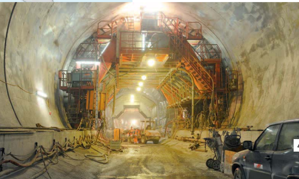
Bild 4. Fertige Innenschale
