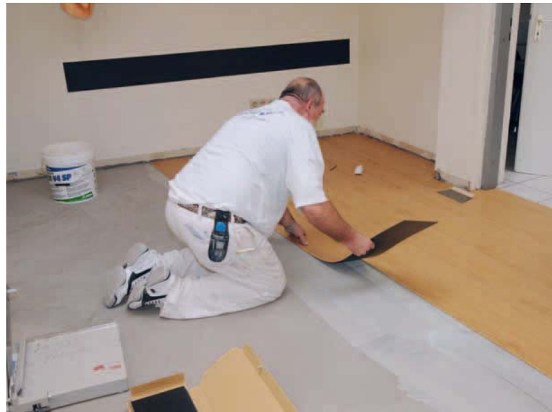
Verlegen des PVC-Designbelags mit ULTRABOND ECO V4 SP
