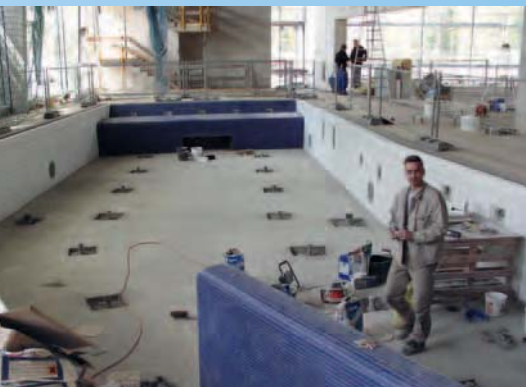
Mit MAPELASTIC abgedichtete Bodenflächen im Schwimmbecken
