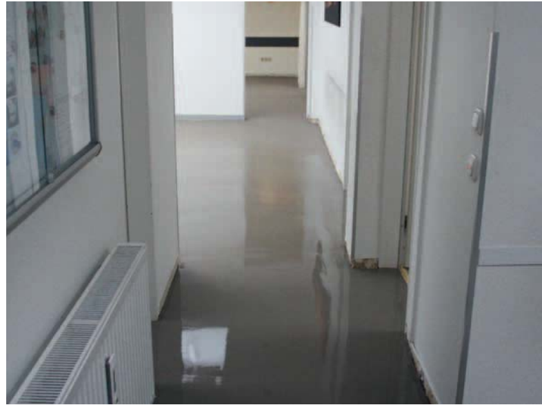
Höhennivellierung mit Bodenausgleichsmasse ULTRAPLAN
