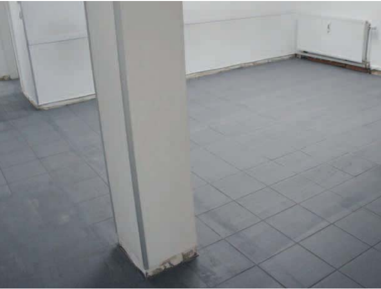
Altbelag vor Beginn der Renovierungsarbeiten
