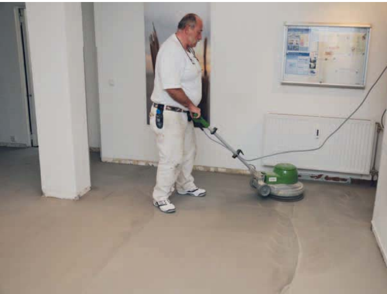
Abschleifen der Bodenspachtelmasse zur Herstellung einer planebenen Oberfläche
