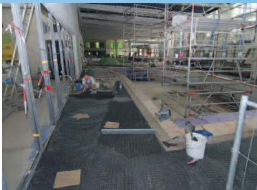
Verfugen des Mosaikbelags mit ULTRACOLOR PLUS
