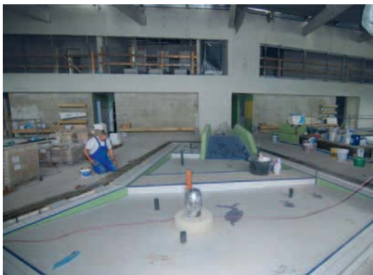
Verlegen des Mosaiks mit ADESILEX P9 auf der Verbundabdichtung MAPELASTIC
