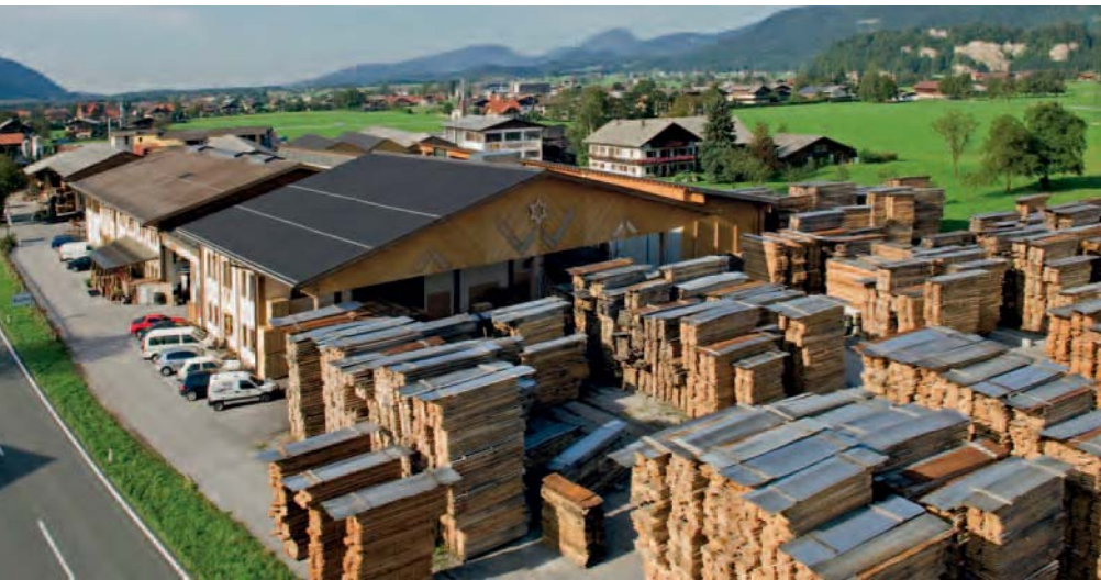
Firmengebäude und Holzlager der WIHO Rupert Wimmer & Co
