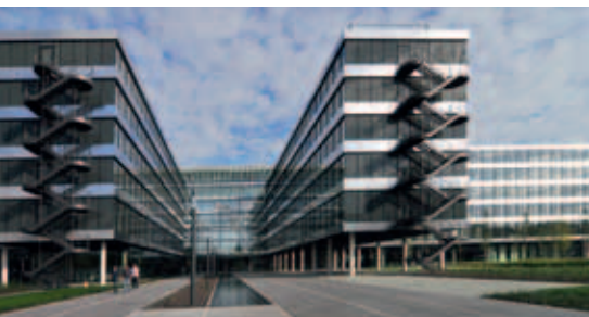
Nachhaltigkeit – die neue HDI-Gerling-Zentrale
