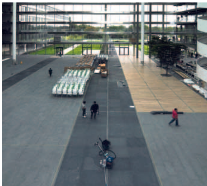
Verlegung der hochwertigen Böden in der Lobby
