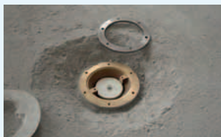
Los-Fest-Flansch-Einbauteil im Schwimmbecken
