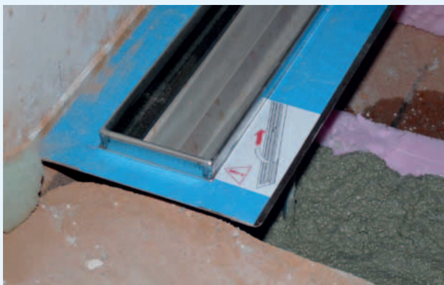
Ablaufrinne mit Flanschaufkantung
