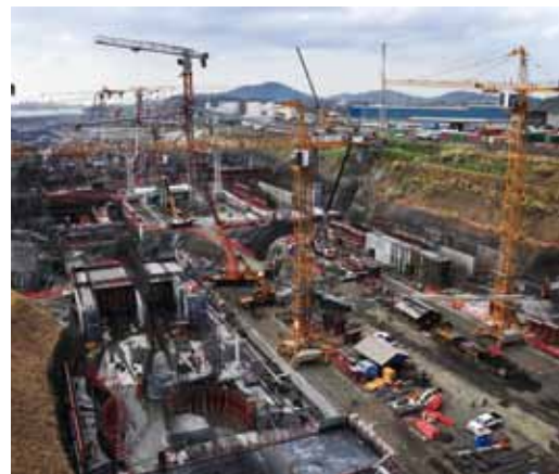
MAPEI-Zusatzmittel wurden zur Anwendung, sowohl beim Massenbeton, als auch bei Betonen, die sich im Bereich des Meerwassers befinden, ausgewählt, um jeweils die Außenseiten und die Innenseiten der Betonschleusen herzustellen
