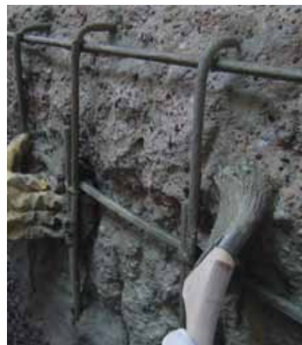
Betoninstandsetzung mit MAPEFER 1K & MAPEGROUT 50 PCC
