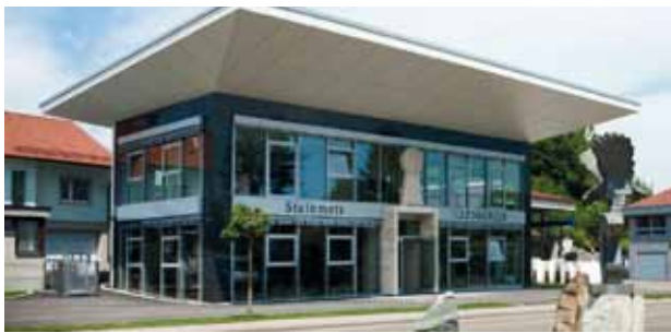
Neues Ausstellungs- und Verwaltungsgebäude Steinmetz Illenberger
