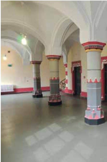
Flurbereich mit verlegtem Linoleum
