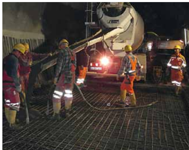
Sohlbetonage Haupttunnel
