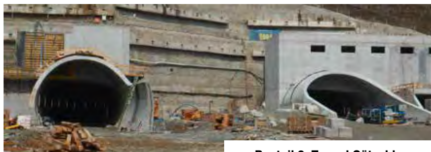
Bauteil 2: Tunnel Götschka
