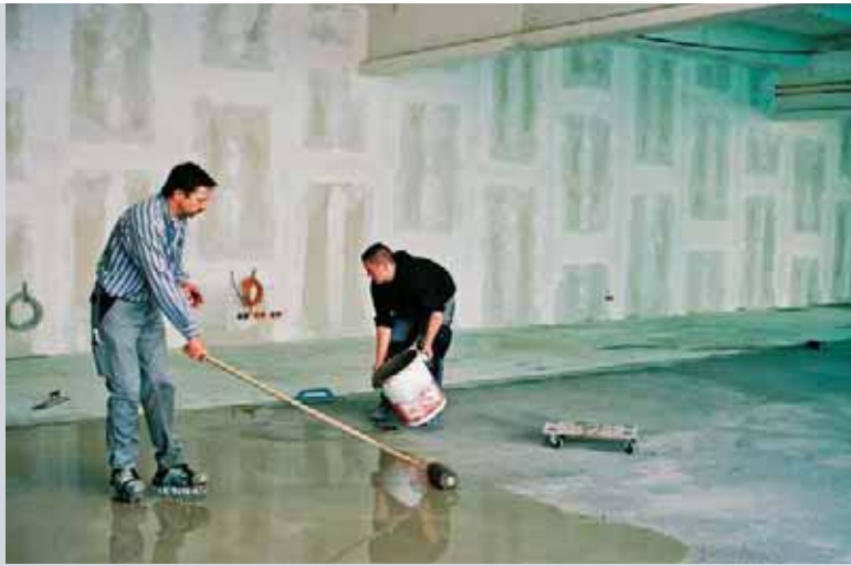
Ausgleichen von Ebenheitstoleranzen mit Ultraplan Maxi auf dem mit Primer MF grundierten Keramikbelag
