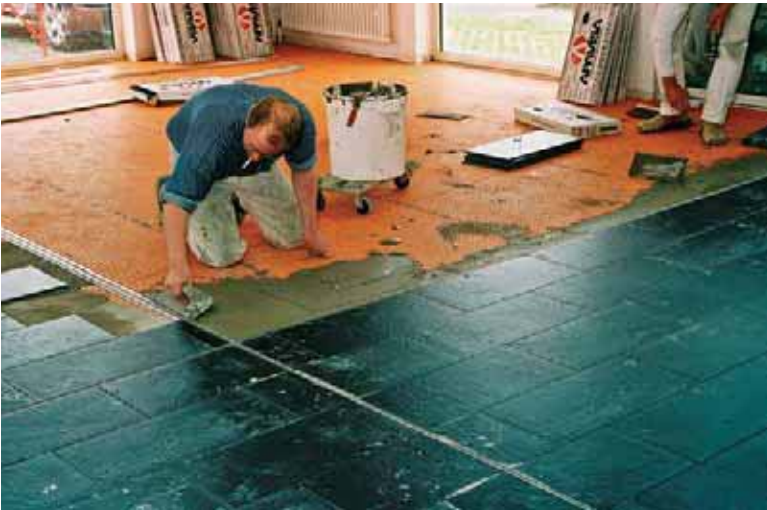
Verlegen der Apovisa-Feinsteinzeugfliesen mit Adesilex P4
