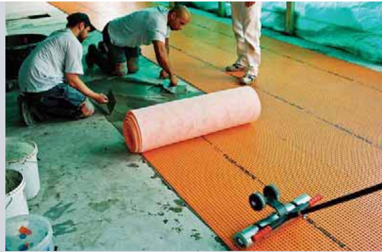
Verkleben der Schlüter-Ditra-Matte mit Adesilex P4 auf Ultraplan Maxi
