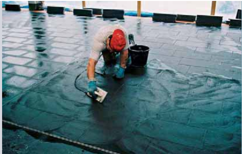
Verfugen des Keramikbelags mit Ultracolor
