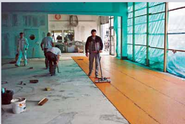
Zusätzliches Anpressen von Schlüter-Ditra mittels Rollenwalze
