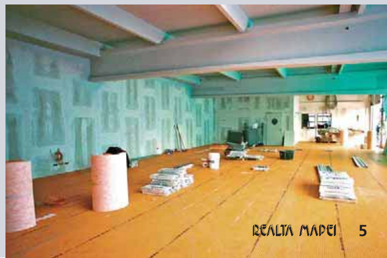
Mit Schlüter-Ditra-Matte entkoppelte Bodenfläche vor der Keramikverlegung
