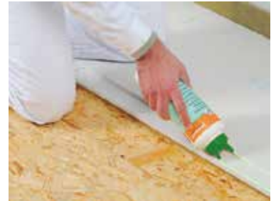
Im Falzbereich den Fermacell greenline Estrichkleber auftragen.
