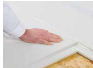
Verkleben des zweiten Elements mit vollständig gefüllten Fugen.
