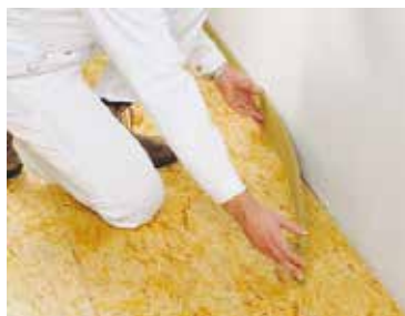
Zunächst Dämmstreifen verlegen und in den Ecken stumpfstößen.
