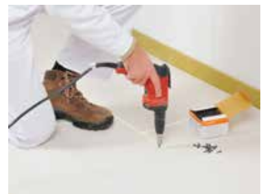
Zum Schluss die Platten durch Verschrauben befestigen.
