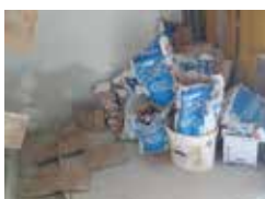
Wohnhausanlage in Langenzersdorf
