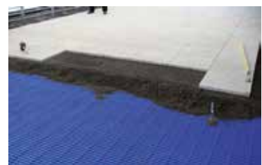
Das MAPEI BDC-System ist eine Verbundkonstruktion, die die schadefreie Verlegung von großformatigen Fliesen auf Terrassen und Balkonen erlaubt.
