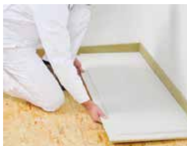
Dann das erste Fermacell Estrich-Element verlegen.
