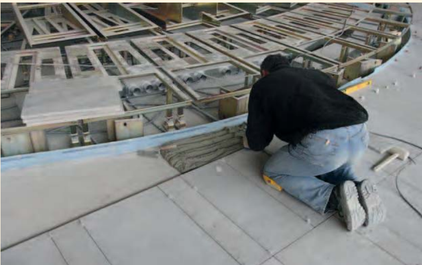
Verlege- und Verfugungsarbeiten ...
