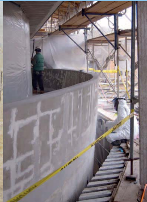
2007–2008: Reparatur bestimmter Bereiche der kreisförmigen Außenfassade des Museums mit PLANITOP XS-Mörtel
