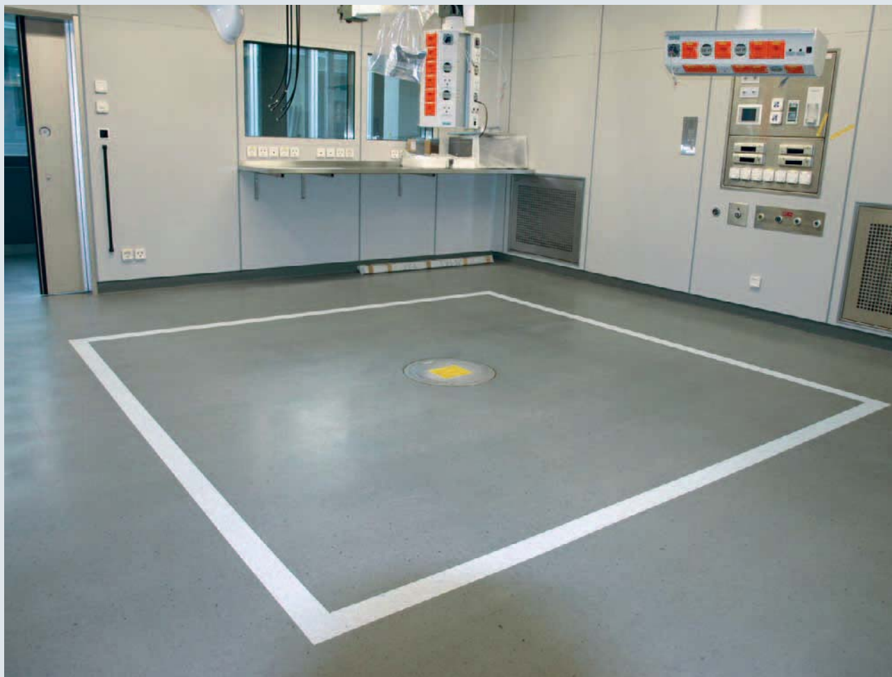
MAPEI war von der Planungsphase bis zur Fertigstellung maßgebend an der Realisierung der Bodenbeläge beteiligt
