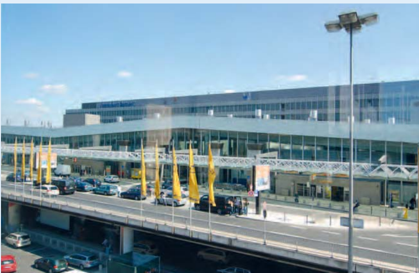
Flughafen Frankfurt, Teilansicht des Terminals 1
