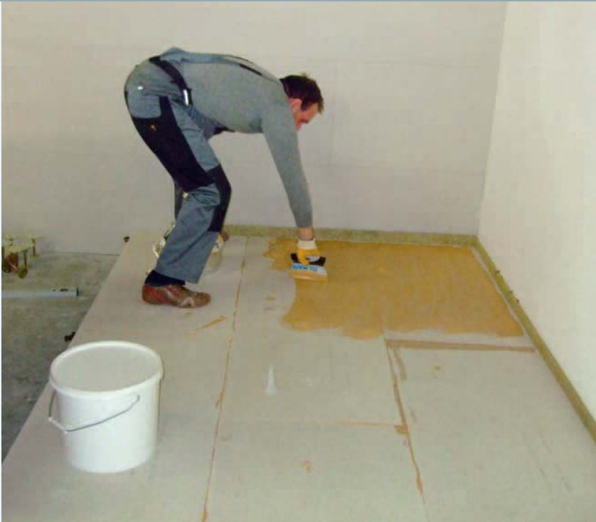
Auftrag von ULTRABOND ECO P991 1K zur Verlegung der zweiten Lage beim Trockenhohlboden
