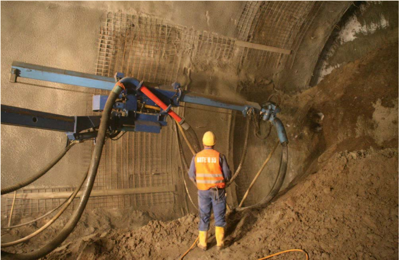
Spritzen auf vereistem Untergrund. Das Spritzbild im Bereich des direkt vor der Ortsbrust eingespritzten Bogens unterstreicht das gute Funktionieren des Spritzbetons auf dem vereistem Untergrund
