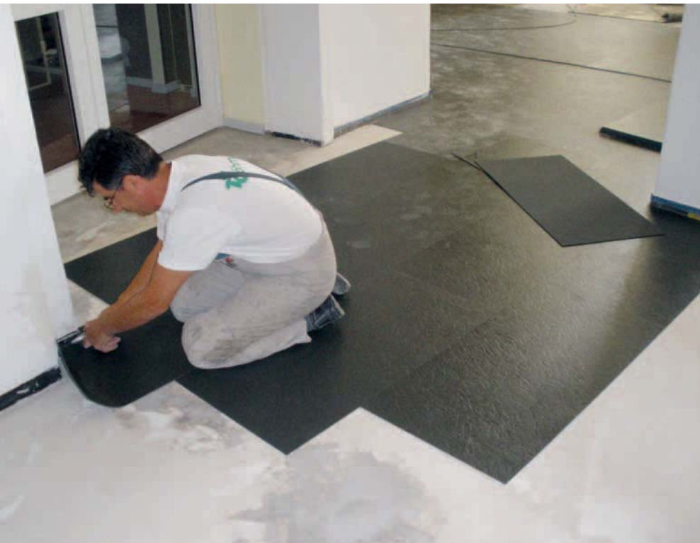
Einbau großformatiger Kautschukplatten mit den professionellen Verlegeprodukten aus dem MAPEI-Sortiment
