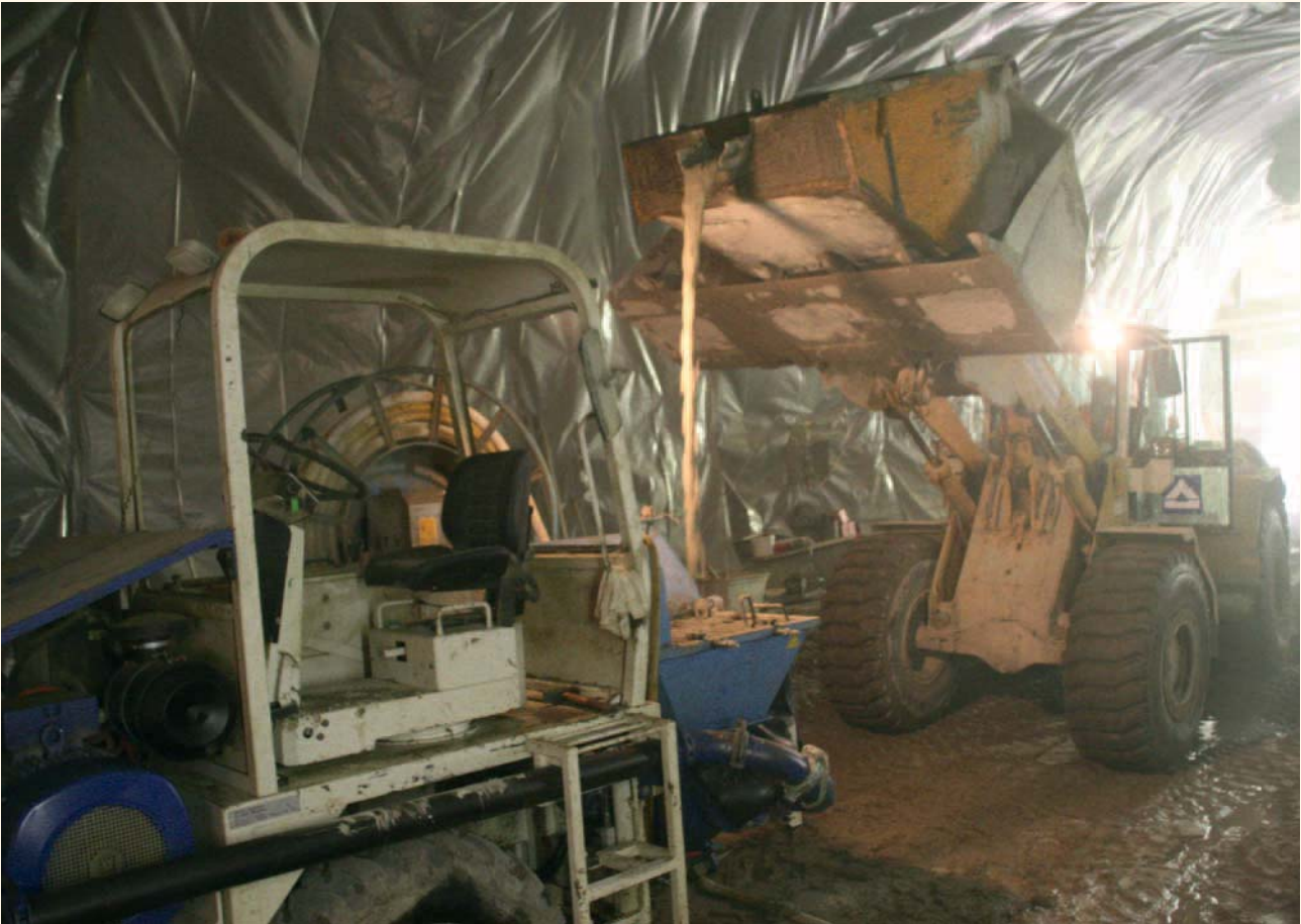
Per Radlader zum Spritzmobil transportiertes Bereitstellungsgemisch. Der Beton bietet sich trotz „unruhigem“ Transport mittels Radlader homogen dar. Keine Entmischungen infolge großer Fallhöhe
