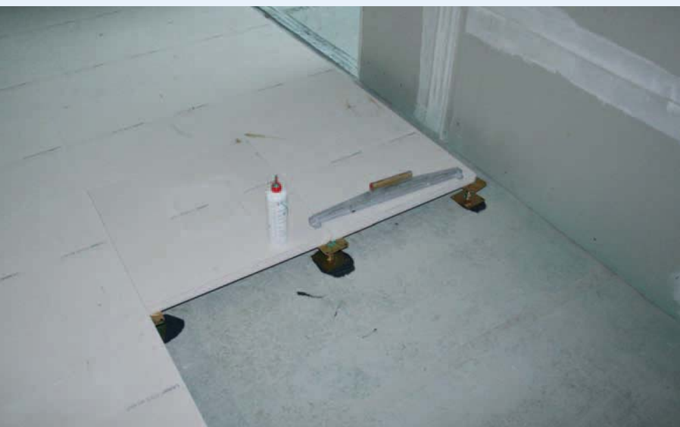
Aufbau eines Trockenhohlbodens auf der Baustelle
