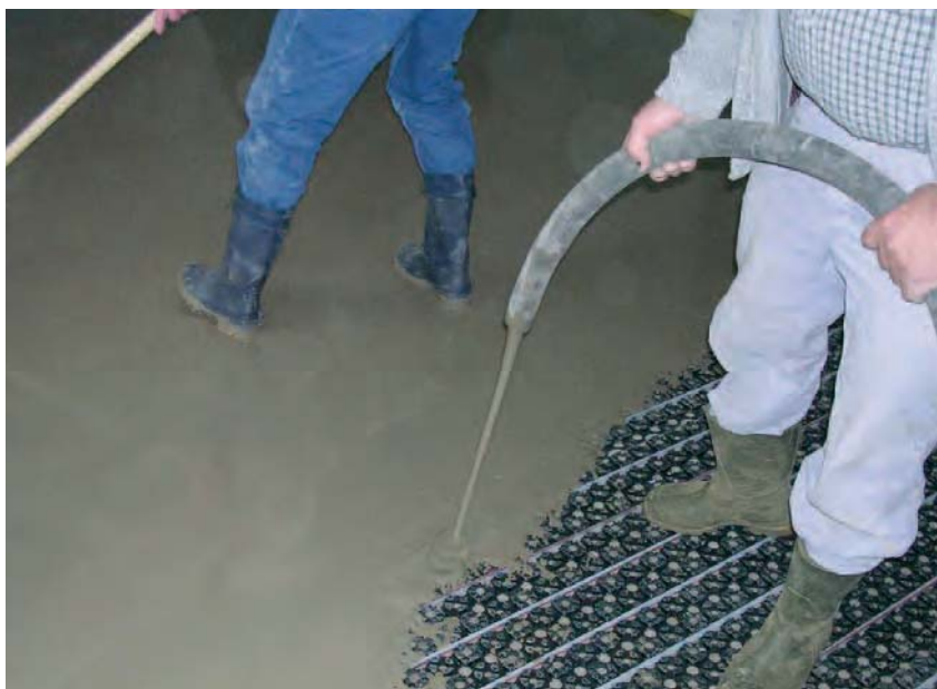
Aufbringen der Fließspachtelmasse ULTRAPLAN MAXI
