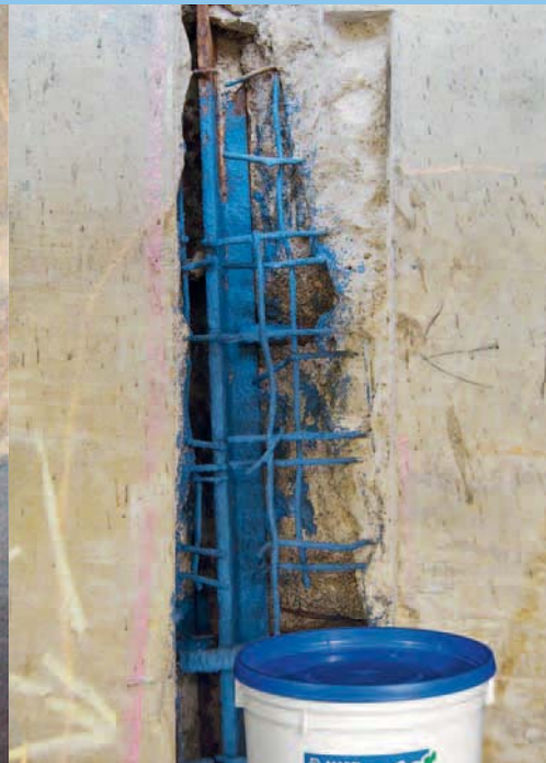
2007: Schutz der Bewehrungsstangen durch MAPEFER 1K
