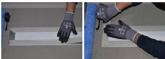
Rinnen-Dichtflansch abkleben
