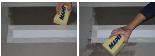
Untergrund vornässen & mattfeucht lassen
