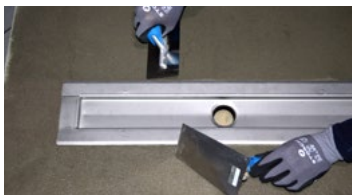
Gefälleausgleich mit Planitop Fast 300
