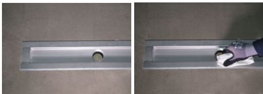
Dichtflansch der Rinne reinigen und entfetten
