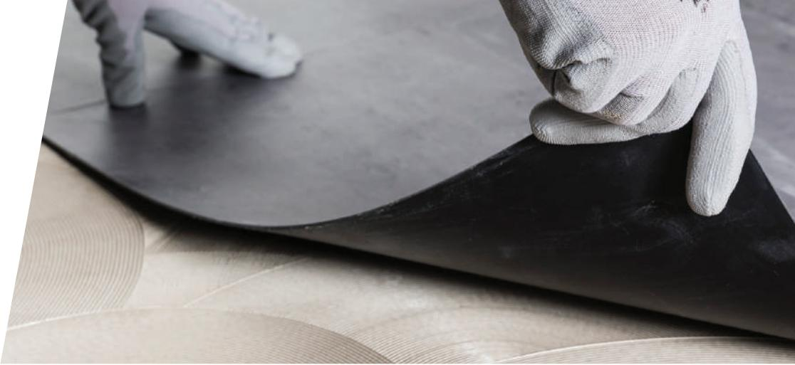
De installatie van te verlijmen LVT vereist geschikte lijmen met een uitstekende hechting en dimensionele stabiliteit. De LVT-lijmen van Mapei zijn speciaal ontwikkeld en getest om de duurzaamheid van vloerbekleding te garanderen en om openstaande naden te voorkomen wanneer de vloer wordt blootgesteld aan temperatuurschommelingen, direct zonlicht of hitte.
