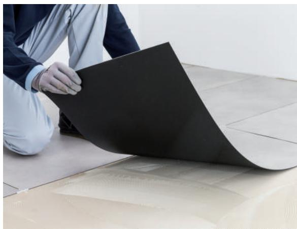
Colle en dispersion avec une haute résistance au cisaillement, formant un film dur et permettant d'afficher le revêtement en lit de colle humide. Améliorée par l'ajout de fibres, donc particulièrement adaptée au passage intensif des environnements résidentiels, commerciaux et industriels (hôpitaux, centres commerciaux, aéroports, etc.)
