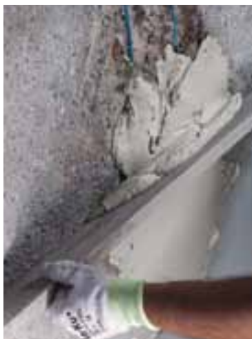
Lissage de Planitop Rasa & Ripara avec une règle
