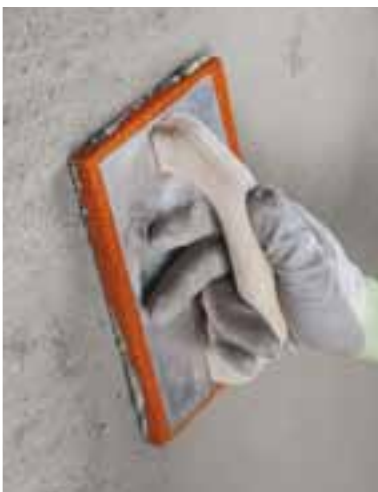
Talochage de la surface du Planitop Rasa & Ripara
