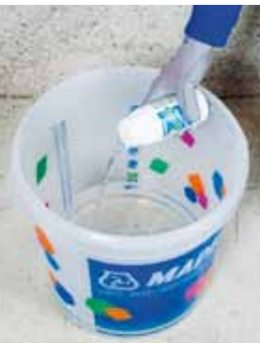
Ajout de Mapetard ES à l'eau de gâchage de Planitop Rasa & Ripara
