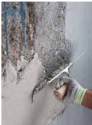
Application de Planitop Rasa & Ripara à la truelle de finition
