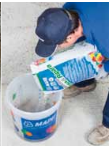
Ajout de Planitop Rasa & Ripara à l'eau de gâchage additionné de Mapetard ES
