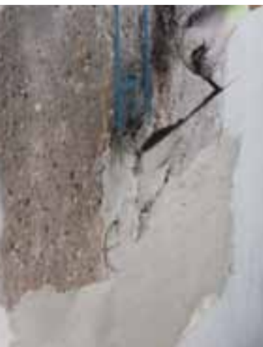
Application de Planitop Rasa & Ripara à la truelle
