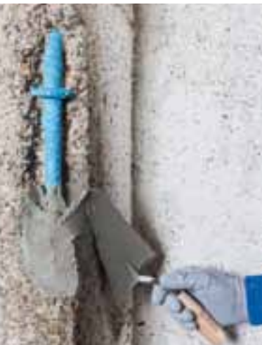
Application de Planitop Rasa & Ripara R4 à la truelle
