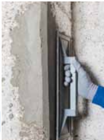
Talochage de la surface du Planitop Rasa & Ripara R4 pour un fini lisse
