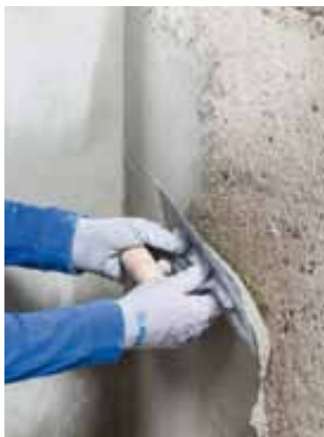
Application de Planitop Rasa & Ripara R4 à la truelle de finition
