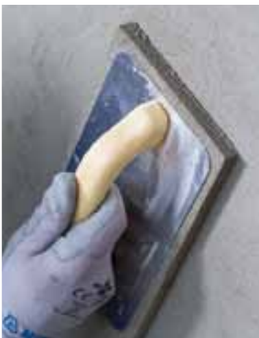
Talochage de la surface du Planitop Rasa & Ripara R4
