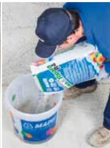
Ajout de Planitop Rasa & Ripara R4 à l'eau de gâchage additionné de Mapetard ES
