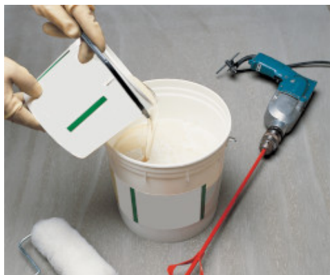
Mélange du composant B avec le composant A
