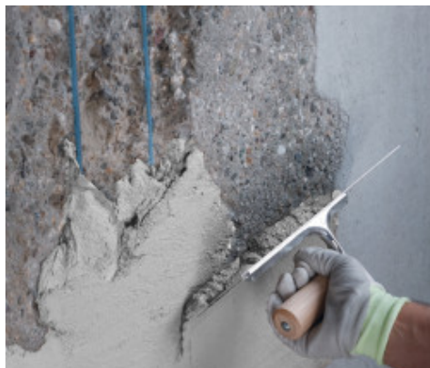
Met een spaan aanbrenge van Planitop Rasa & Ripara
