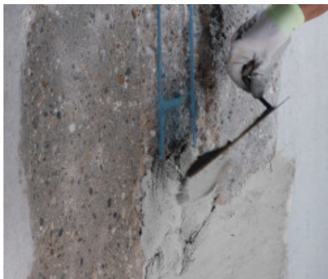
Met een troffel aanbrenge van Planitop Rasa & Ripara
