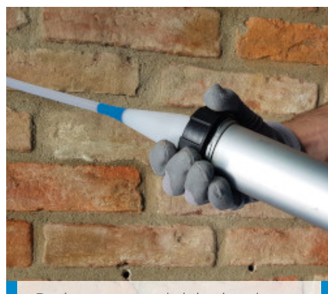
De ringmoer met de injectietool op het kitpistool vastdraaien
