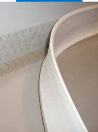
Application de plinthe de PVC plastifiée avec Mapecontact
