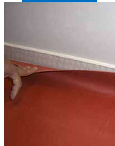
Formation d'un coin d'angle avec Mapecontact
