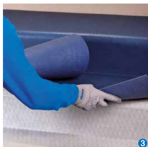
3 Application de PVC sur une marche d'escalier avec Mapecontact
