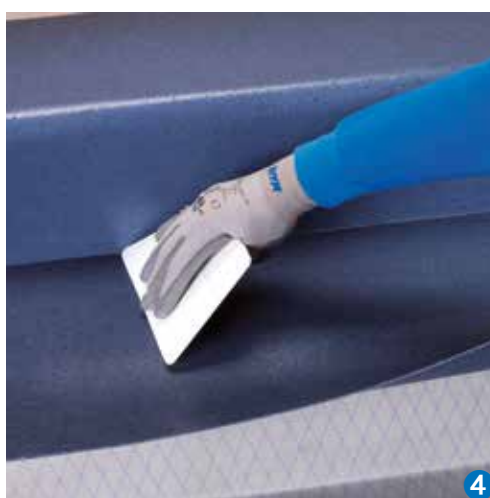
4 Marouflage du PVC après l'application de Mapecoat
