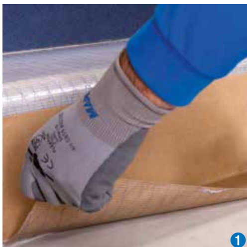
1 Positionnement de Mapecontact sur une contremarche
