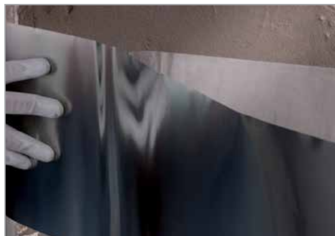
Εφαρμογή του Mapeshield E 25 στην εξωτερική επιφάνεια της κατασκευής
