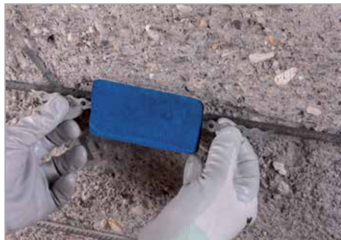
Εφαρμογή του Mapeshield I σε μια κατασκευή υπό επισκευή
