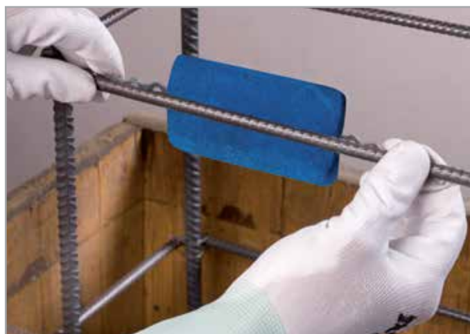
Εφαρμογή του Mapeshield I σε μια νέα κατασκευή
