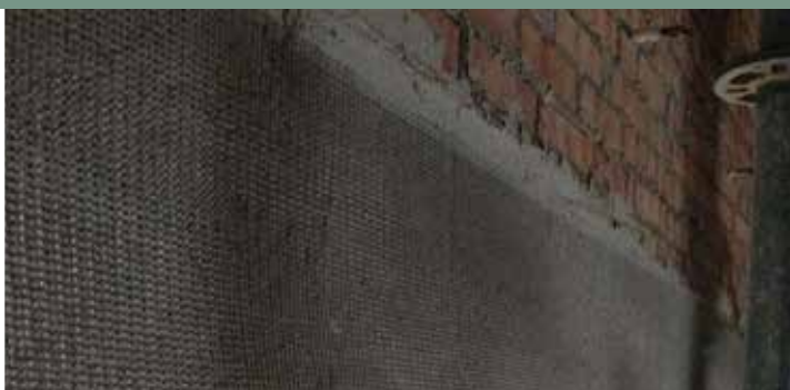
4 | Ενίσχυση διάτμησης τοίχων ανάμεσα σε κολώνες με Mapegrid G220 και Planitop HDM Maxi Δημοτικό σχολείο Sant'Agostino - Ascoli Piceno
