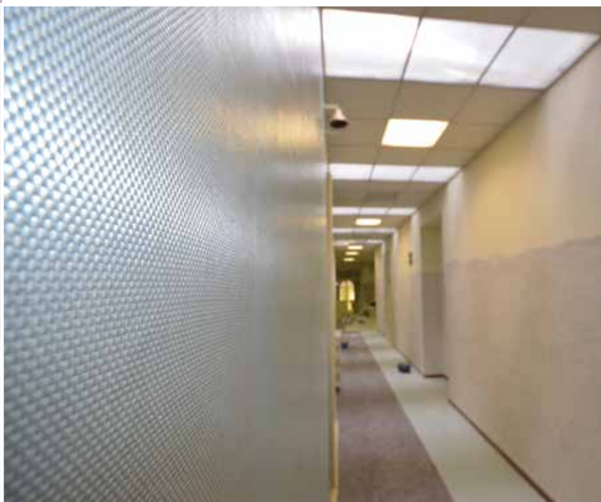
2 | Σύστημα κατά της κατάρρευσης για διαχωριστικούς τοίχους χρησιμοποιώντας το MapeWrap EQ System Γυμνάσιο Dante Alighieri - Gorizia
