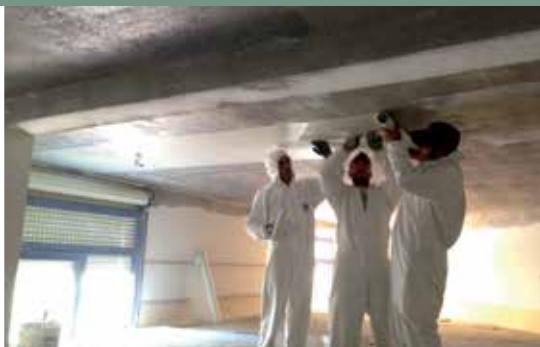
1 | Αντισεισμική προστασία με εφαρμογή του MapeWrap EQ System σε οροφή - San Vincenzo (Λιβόρνο)
