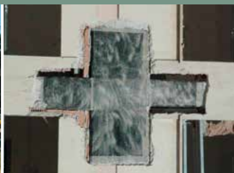
5 | Ενίσχυση ενός σημείου άρθρωσης δοκού-κολώνας με ύφασμα MapeWrap C . "Schools Project" - L'Aquila
