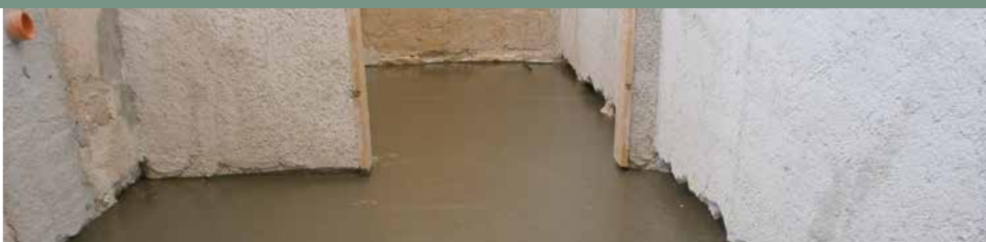
3 | Ενίσχυση της άνω επιφάνειας ενός δαπέδου με έγχυση Planitop HPC Floor Σχολείο Mons. Giovanni Bacile - Bisacchino (Παλέρμο)
