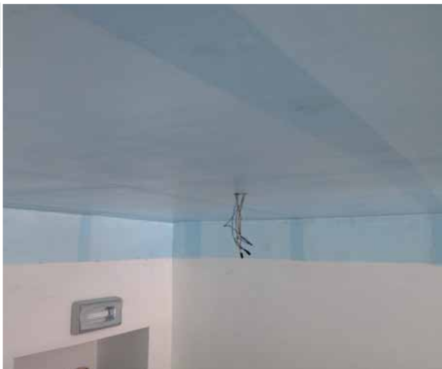
1 | Σύστημα κατά της κατάρρευσης για οροφές χρησιμοποιώντας το MapeWrap EQ System Ενιάιο σχολείο "Mother Teresa of Calcutta" - Toro (Campobasso)
