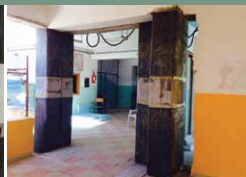
6 | Ενίσχυση διάτμησης υποστυλωμάτων με ύφασμα MapeWrap C - Δημοτικό σχολείο περιφέρειας Mirto - Crosia (Cosenza)
