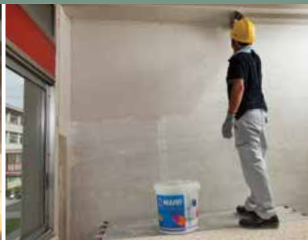
2 | Αντισεισμική προστασία με εφαρμογή του MapeWrap EQ System σε διαχωριστικούς τοίχους - Ενιαίο σχολείο Teresio Olivelli - Darfo Boario Terme (BS)
