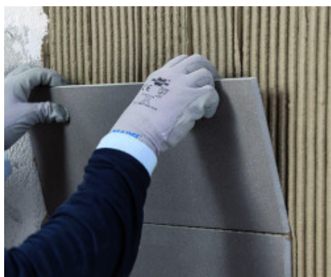
Τοποθέτηση τεχνητού γρανίτη κάθετα σε τοίχο
