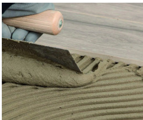
Τοποθέτηση τεχνητού γρανίτη με όψη ξύλου σε δάπεδο
