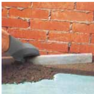
Applicazione di massetto cementizio aderente additivato con Planicrete
