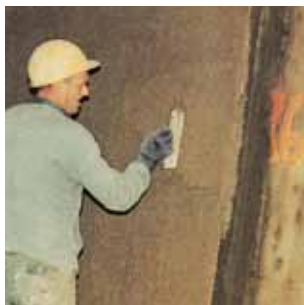
Intonaco cementizio con Planicrete . Cantiere Tunnel autostradale Ville Marie Montreal – Canada
