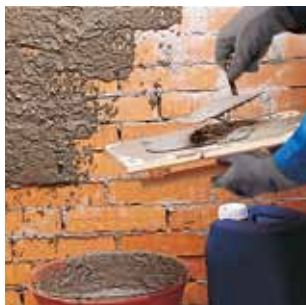
Rinzafo additivato con Planicrete
