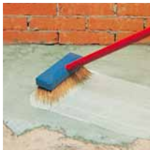
Applicazione di boiacca cementizia additivata con Planicrete
