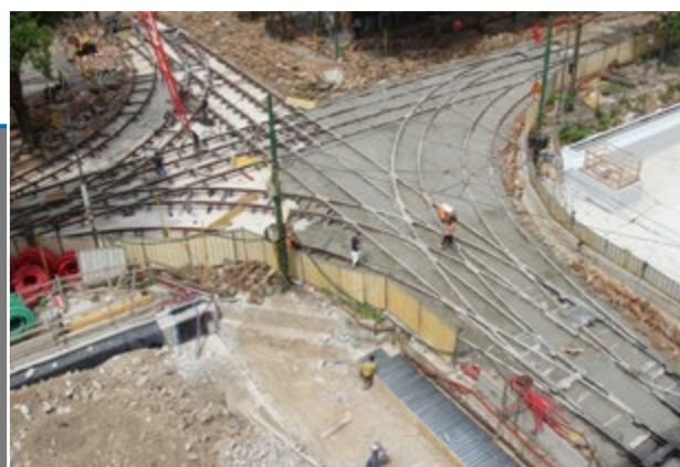
Esempio di fondazione in calcestruzzo fibrorinforzata con IBETON 39 .
