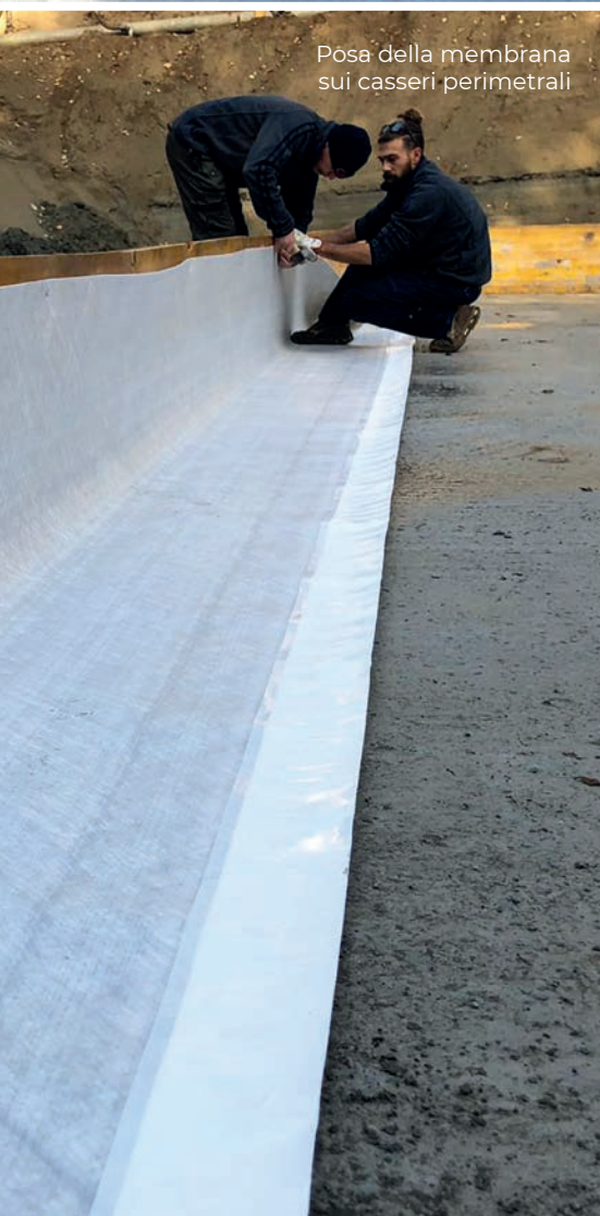
Impermeabilizzazione pali
