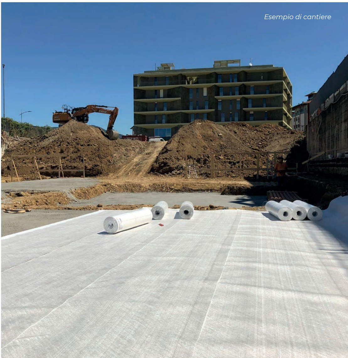
Posa delle armature
