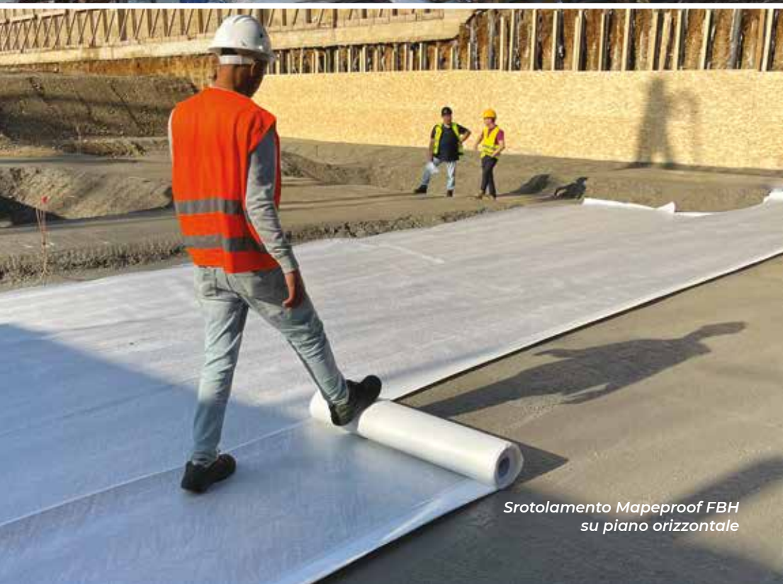
Area di cantiere
