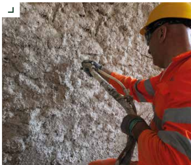
Applicazione a spruzzo di PLANITOP INTONACO ARMATO
