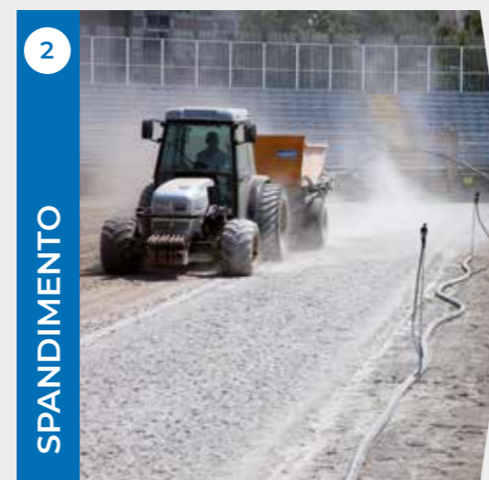
Spandimento di Mapesoil 100 con sabbiatrice
