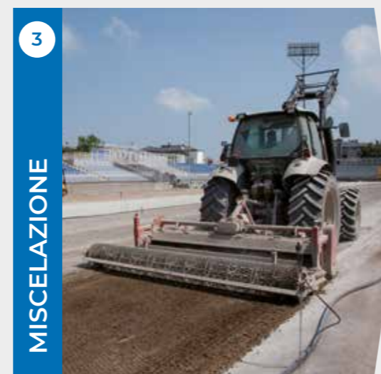
Miscelazione di Mapesoil 100 con fresa
