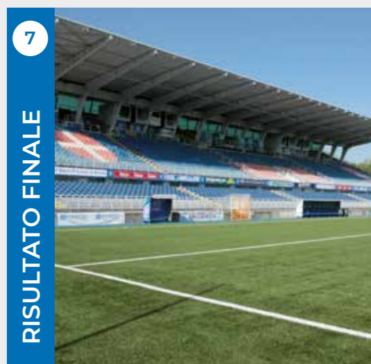
Campo in erba sintetica a drenaggio orizzontale realizzato con Mapesoil 100
