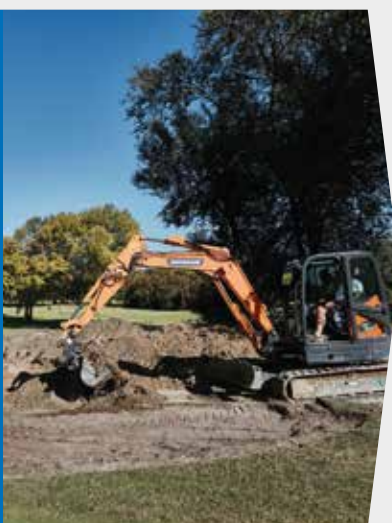
Rimozione della vecchia sabbia
