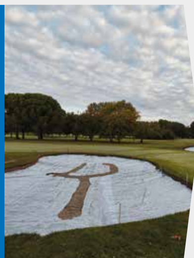
Realizzazione di flow-layer con telo impermeabile
