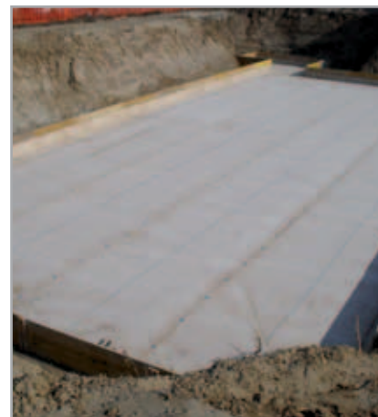
Fig. 3.1 - Impermeabilizzazione sottoplatea in pre-getto
