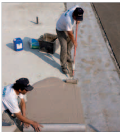
Fig. 3.9 - Impermeabilizzazione con MAPELASTIC SMART e MAPETEX SEL
