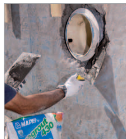
Fig. 4.3 - Ripristino del supporto con MAPEGROUT 430
