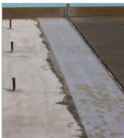
Fig. 3.10 - Impermeabilizzazione con MAPELASTIC SMART e MAPETEX SEL
