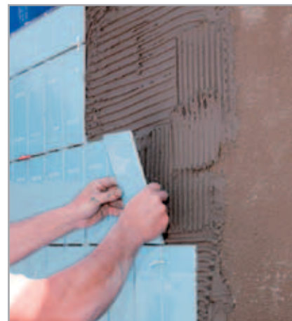
Fig. 5.2 - Incollaggio a parete con KERABOND miscelato con ISOLASTIC
