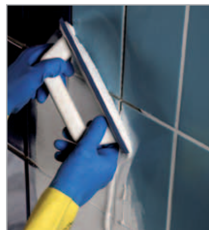
Fig. 5.6 - Stuccatura del rivestimento con KERAPOXY CQ
