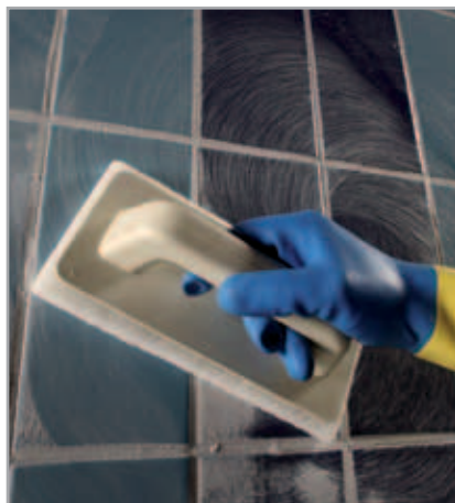
Fig. 5.7 - Pulizia del rivestimento con Scotch Brite
