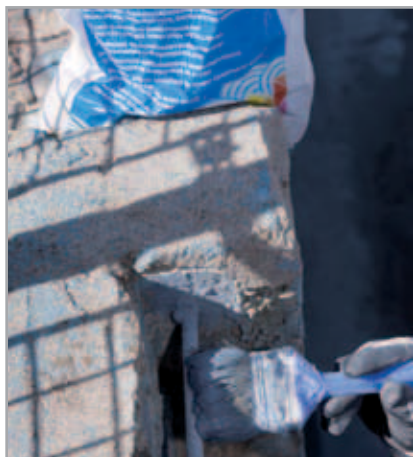
Fig. 4.1 - Applicazione di MAPEFER 1K su ferri di armatura
