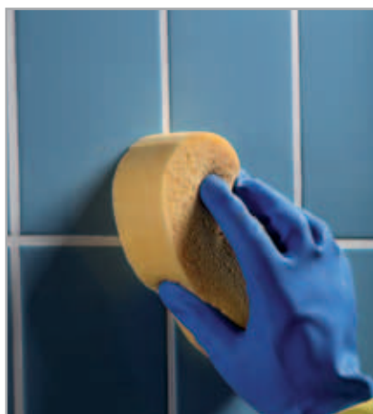
Fig. 5.8 - Pulizia finale con spugna pulita
