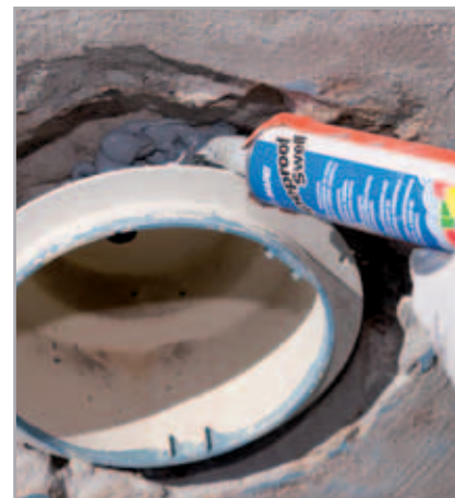
Fig. 4.2 - Sigillatura con MAPEPROOF SWELL
