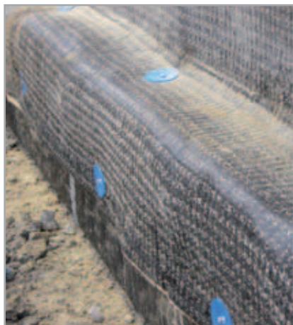
Fig. 3.3 - Impermeabilizzazione al piede della struttura
