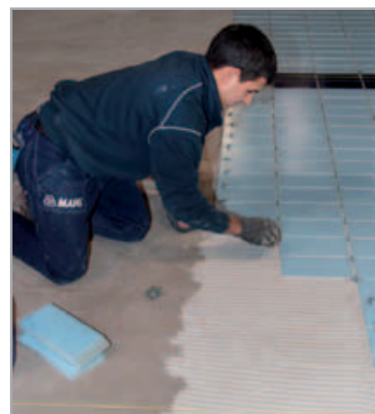
Fig. 5.3 - Posa del rivestimento sul fondo vasca
