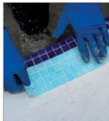
Fig. 5.4 - Posa del rivestimento a mosaico
