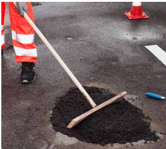
2. Applicazione e stesura di Mape-Asphalt Repair 0/8
