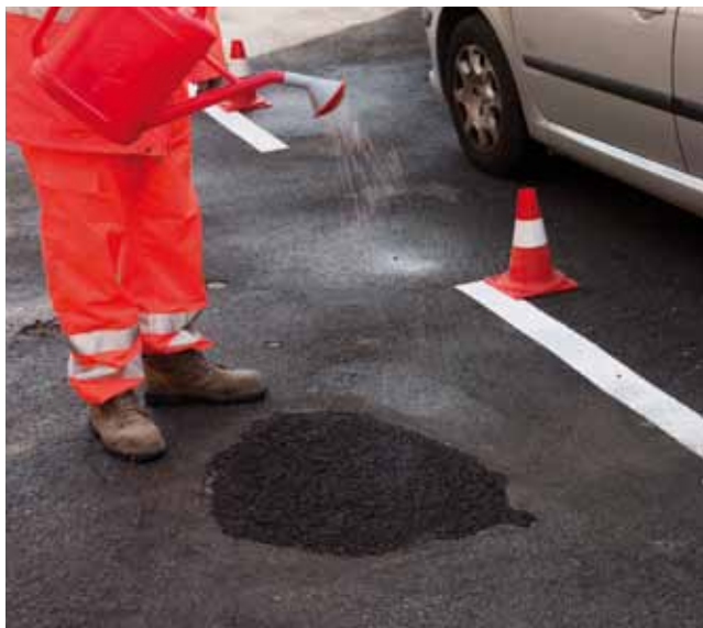
3. Bagnatura della superficie di Mape-Asphalt Repair 0/8
