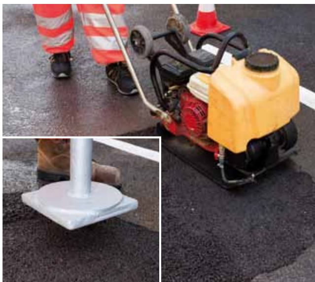
4. Compattazione manuale o meccanica di Mape-Asphalt Repair 0/8
