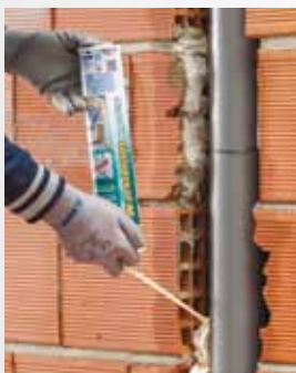
Applicazione manuale MapePUR Universal Foam M
