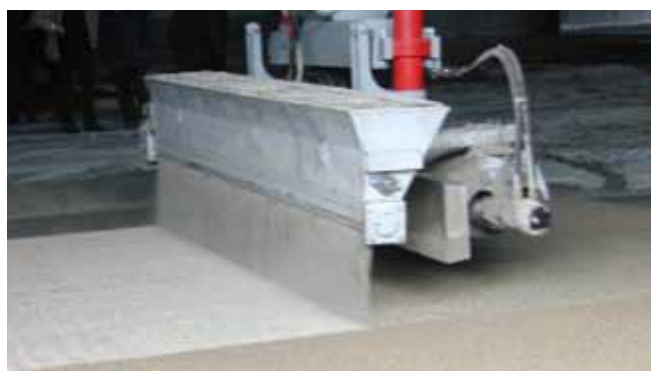
Applicazione meccanica di Mapetop N AR6
