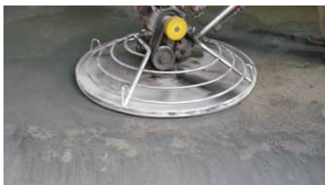
Lisciatura mediante vibrocompattatrice meccanica
