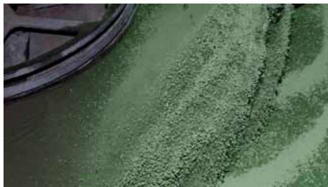
Applicazione manuale di Mapetop N AR6
