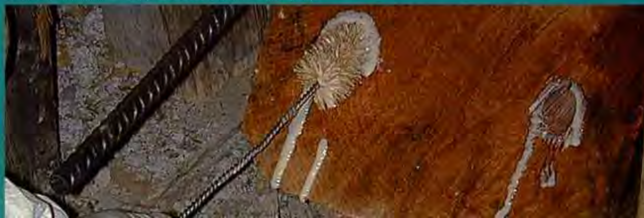
FIGURA 21 - Applicazione di MAPEWOOD PRIMER 100 mediante scovolino
