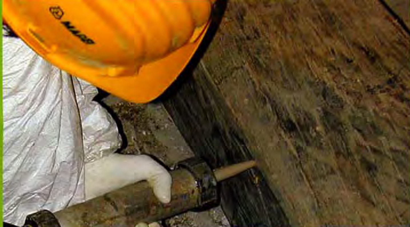
FIGURA 8 - Operazione di restauro di un solaio ligneo
