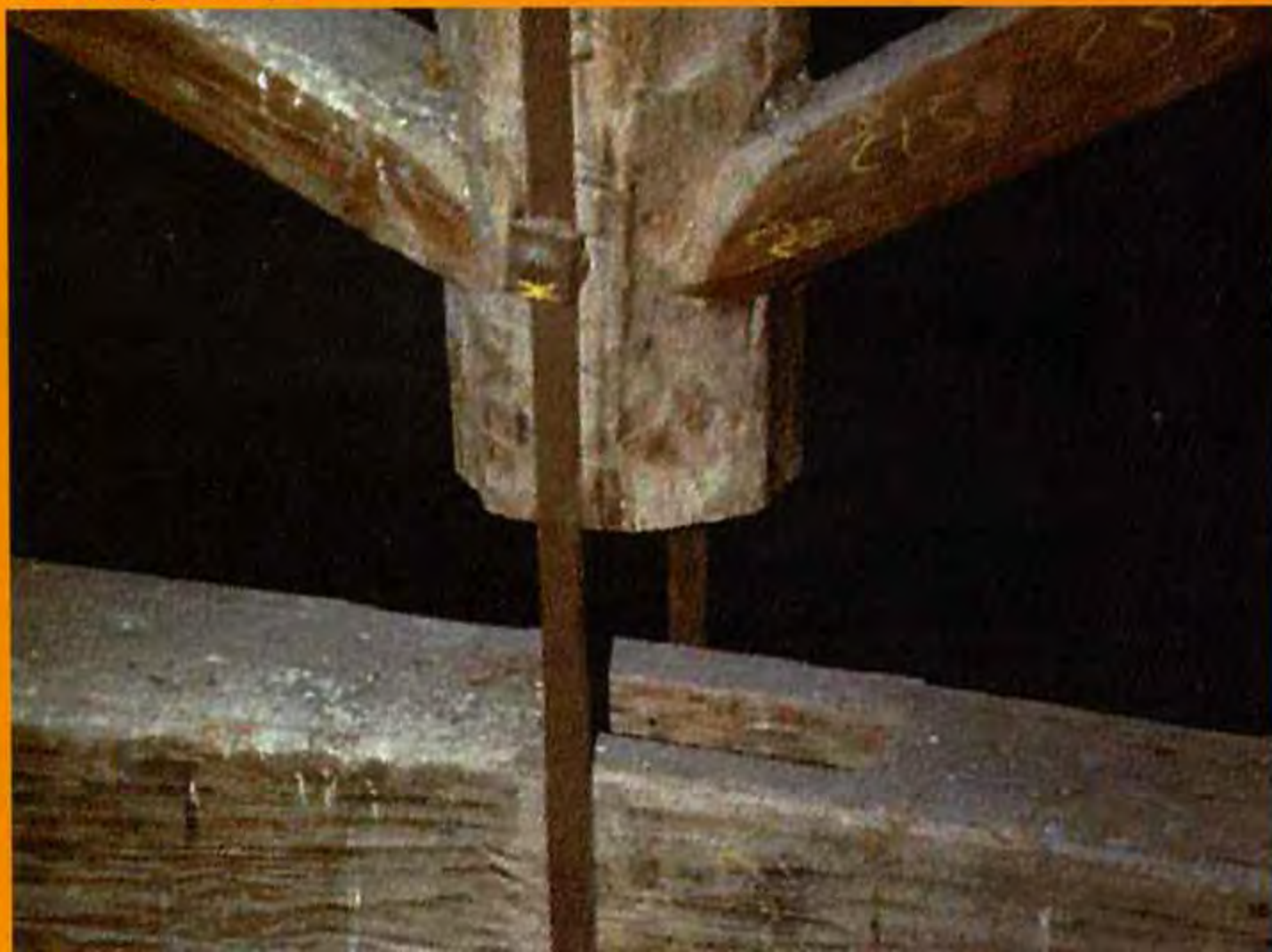
FIGURA 11 - Dettaglio di orditura lignea
