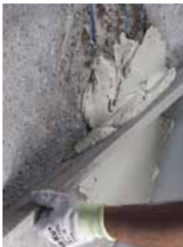
Staggiatura di Planitop Rasa & Ripara
