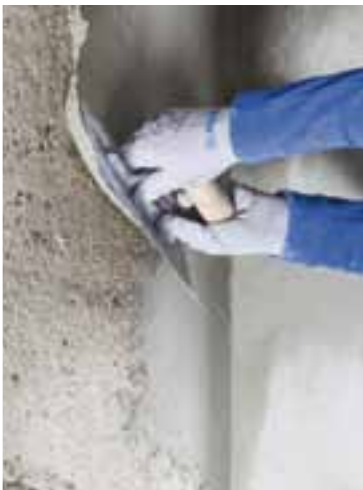
Applicazione a spatola di Plantop Rasa & Ripara R4
