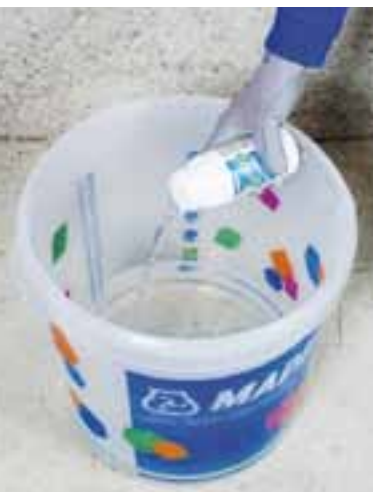
Aggiunta di Mapetard ES all'acqua d'impasto di Planitop Rasa & Ripara
