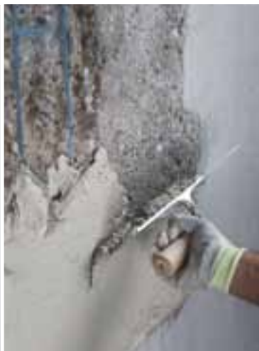
Applicazione a spatola di Planitop Rasa & Ripara
