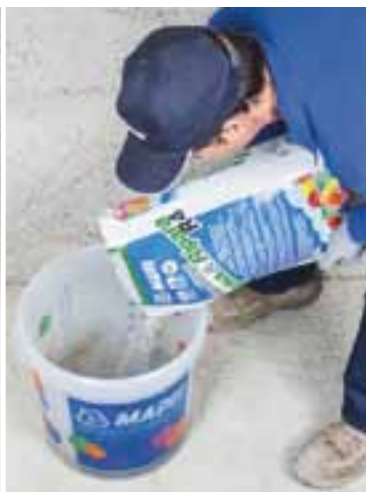
Aggiunta di Planitop Rasa & Ripara all'acqua d'impasto additivata con Mapetard ES
