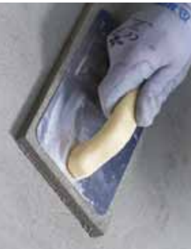
Frattazzatura di Plantop Rasa & Ripara R4
