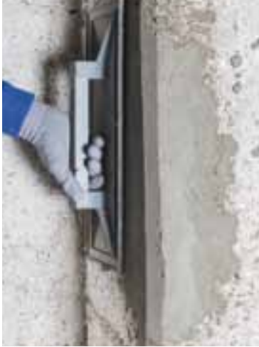
Lisciatura di Plantop Rasa & Ripara R4 con frattazzo
