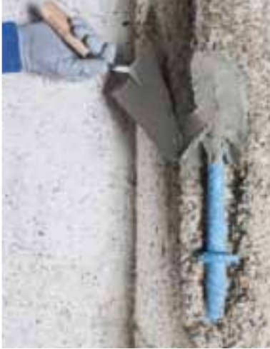
Applicazione a cazzuola di Plantop Rasa & Ripara R4
