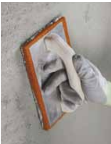
Frattazzatura di Planitop Rasa & Ripara
