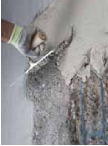
Applicazione a spatola di Plantop Rasa & Ripara
