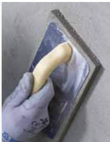
Frattazzatura di Planitop Rasa & Ripara R4
