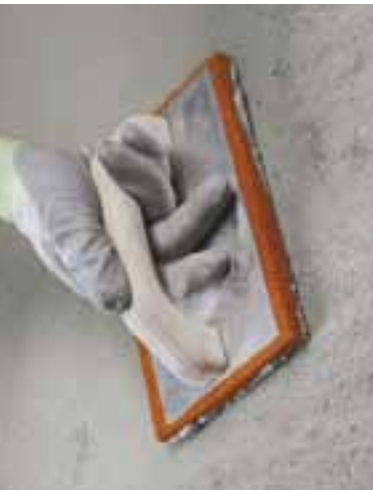
Frattazzatura di Plantop Rasa & Ripara
