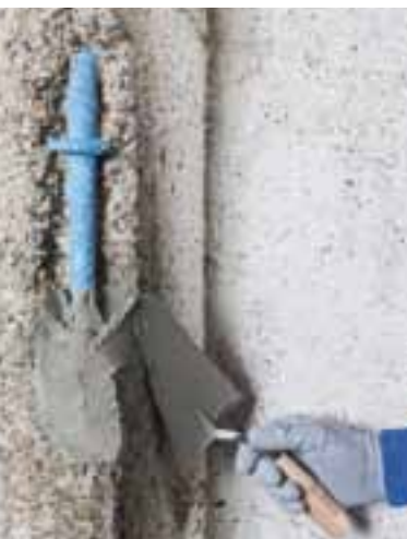
Applicazione a cazzuola di Planitop Rasa & Ripara R4
