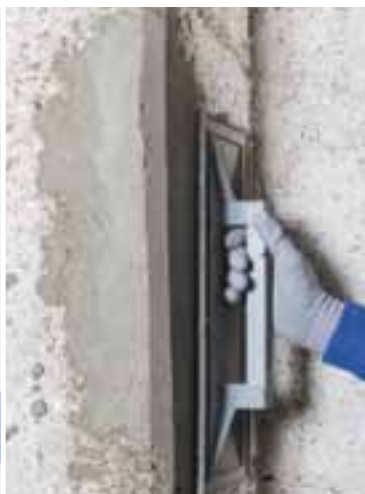
Lisciatura di Planitop Rasa & Ripara R4 con frattazzo
