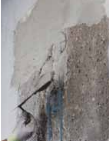
Applicazione a cazzuola di Plantop Rasa & Ripara
