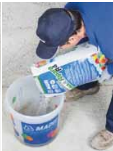
Aggiunta di Planitop Rasa & Ripara R4 all'acqua d'impasto additivata con Mapetard ES
