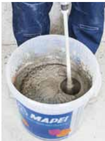
Miscelazione di Planitop Rasa & Ripara R4
