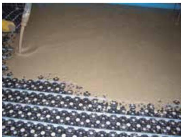
Applicazione di **Ultraplan Maxi** per la realizzazione di pavimento radiante a basso spessore
