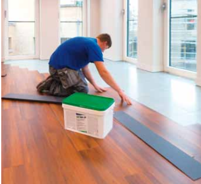
Posa di LVT su film di Ultrabond Eco Tack LVT asciutto
