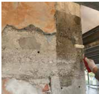
Applicazione del tessuto MapeWrap C QUADRI-AX e applicazione della seconda mano di MapeWrap 31
