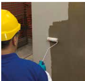
Posa in opera di MapeWrap C UNI-AX
