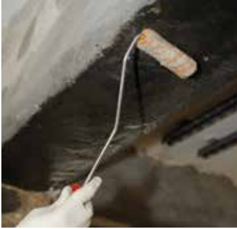
Applicazione di MapeWrap 11/ MapeWrap 12 su Carboplate
