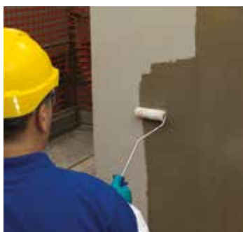
Posa in opera di MapeWrap C UNI-AX HM
