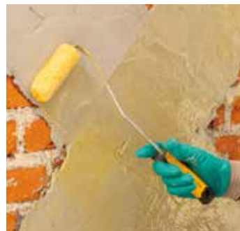
Applicazione prima mano di MapeWrap 31
