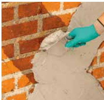
Applicazione di MapeWrap 11/ MapeWrap 12
