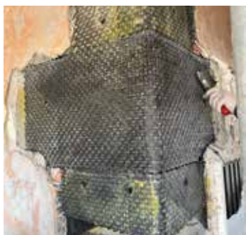
Applicazione del tessuto MapeWrap C QUADRI-AX e applicazione della seconda mano di MapeWrap 31
