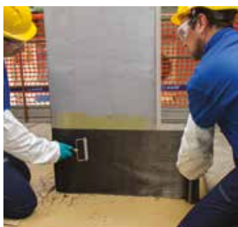
Posa in opera di MapeWrap C UNI-AX
