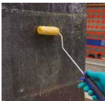
Applicazione della seconda mano di MapeWrap 31
