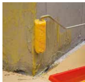
Applicazione della prima mano di MapeWrap 31
