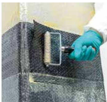
Posa in opera di MapeWrap C UNI-AX HM
