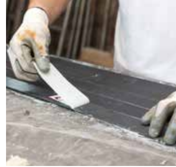
Applicazione di successiva rasatura di MapeWrap 11/ MapeWrap 12
