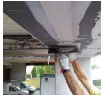
Applicazione di successiva rasatura di MapeWrap 11/ MapeWrap 12
