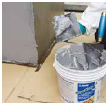
Applicazione della seconda mano di MapeWrap 31
