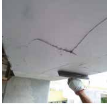
Applicazione di Carboplate
