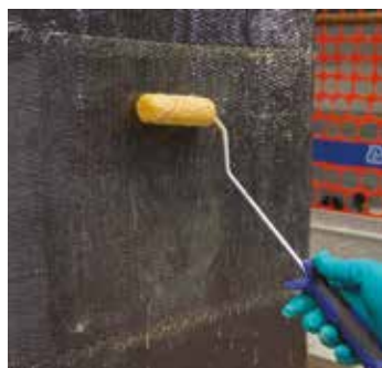
Applicazione della seconda mano di MapeWrap 31
