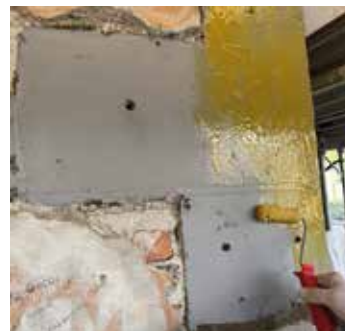
Applicazione della prima mano di MapeWrap 31
