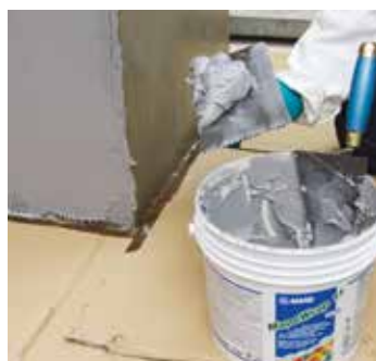
Applicazione di MapeWrap 11/ MapeWrap 12
