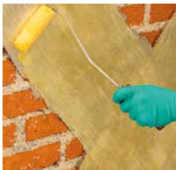
Applicazione seconda mano di MapeWrap 31
