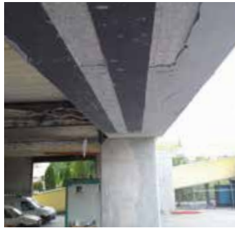
Applicazione di Carboplate
