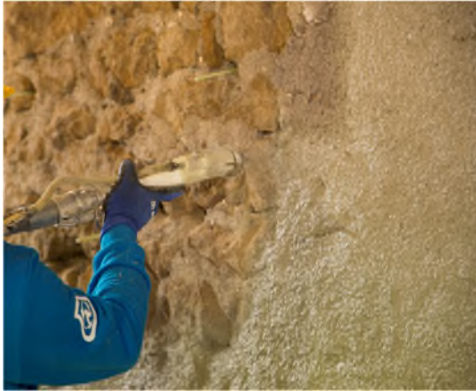
Applicazione primo strato di malta
