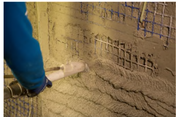
Applicazione secondo strato di malta
