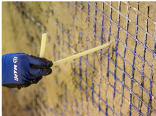
Posa connettori in corrispondenza dei segnalini
