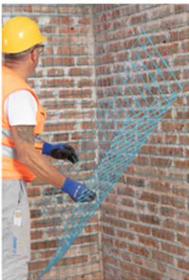
Solo per versioni 66/99: posa rete, angolari e connettori Mapenet EMR e successiva applicazione di malta a spruzzo
