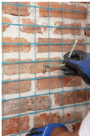
Solo per versioni 66/99: posa rete, angolari e connettori Mapenet EMR e successiva applicazione di malta a spruzzo
