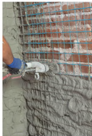
Solo per versioni 66/99: posa rete, angolari e connettori Mapenet EMR e successiva applicazione di malta a spruzzo
