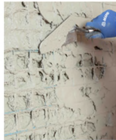
Posa rete e secondo strato di malta
