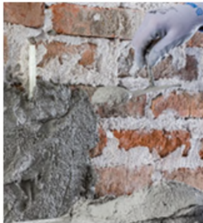
Applicazione primo strato di malta
