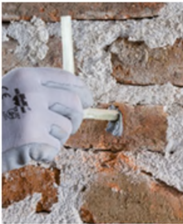
Posa di Mapenet EMR Connector
